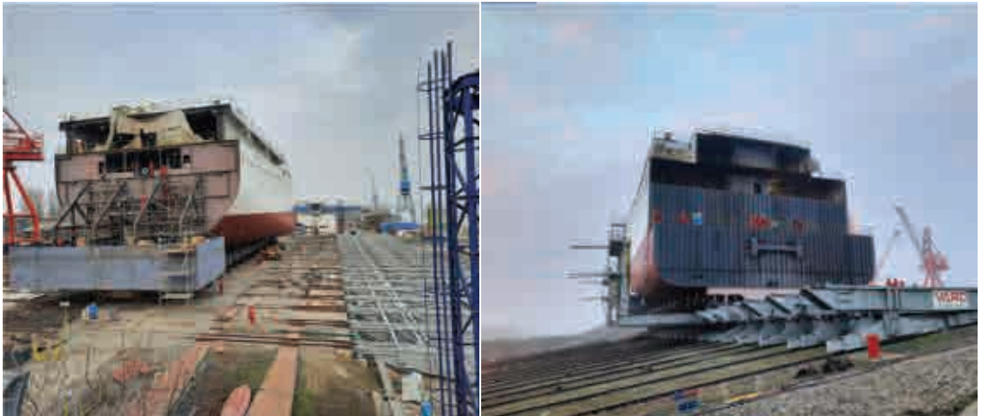
Blocul 6284 pregătit de lansare
