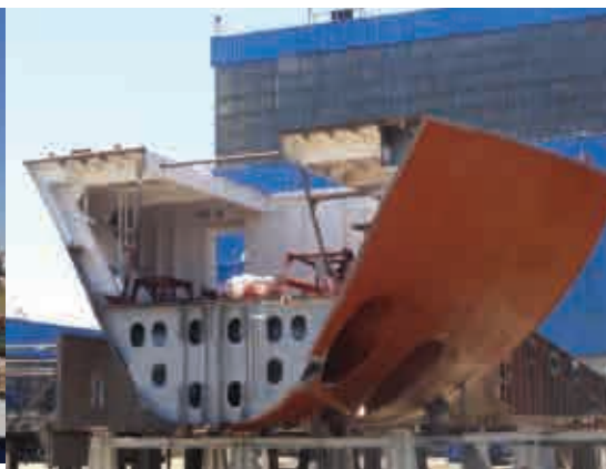
Secție de navă saturată și vopsită
