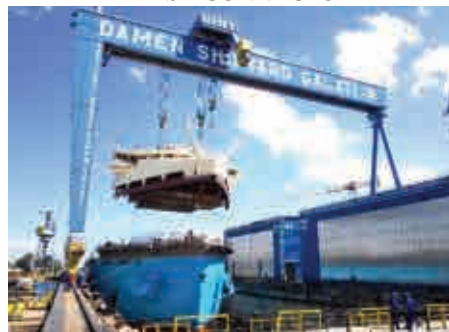
Montarea blocului suprastructurii
