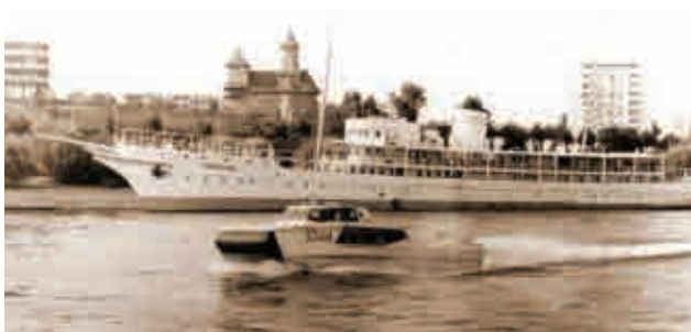
Modelul experimental nava neamfibie pe pernă de aer la Galați
