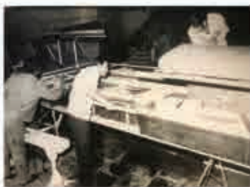
Modelul seminatural în construcție la Atelier Prototipuri ICEPRONAV
